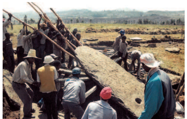
Fig. 2 - La pierre est glissée dans sa fosse d'implantation. Au fur-et-à-mesure du gain d'inclinaison, les hommes s'avancent vers la pierre, le long des perches, glissant leurs épaules dessous. Quand le bloc est suffisamment incliné, c'est-à-dire généralement aux environs de 45°, une corde est tirée dans le sens du mouvement de rotation du monolithe pour achever le redressement. La pierre sera bloquée dans sa rotation à l'aide de perches verticales. Elles seront enlevées peu après (Poissonnier 1996).
