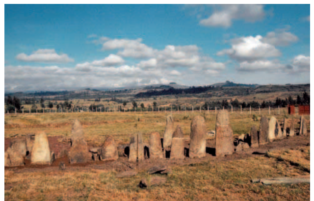
Fig. 3 - Vue du site de Tiya après la restauration qui fut entièrement menée selon ces mêmes techniques (cl. B. Poissonnier).
